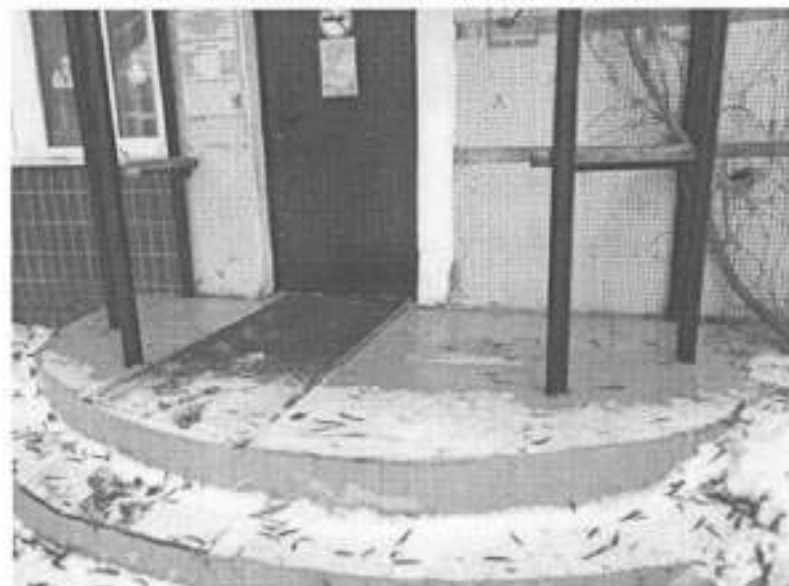
№ 4. Входная площадка (перед дверью)
